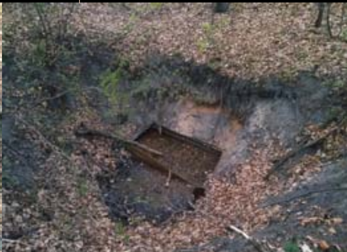
Zapadlisko z widoczną obudową szybu jednej z kopalń
