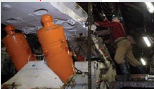
Montaż kompletnych sekcji obudowy z dostarczonych elementów w komorze montażowej (ujęte na zdjęciu otrzymanym z kopalni)
