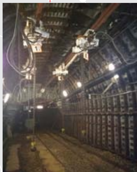
Komora po modernizacji
