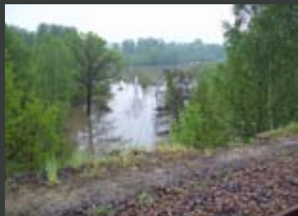
Powodziowe rozlewisko dużej rzeki u podstawy obiektu inżynierskiego (nasypu kolejowego), położonego w czynnym terenie górniczym - stan dla wielkiej wody z maja 2010 r.
