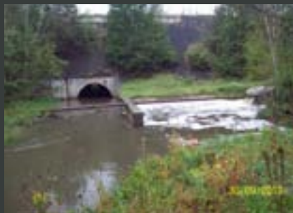
Przykład podtopionego w wyniku obniżenia górniczych przepustów pod nasypem kolejowym, położonym w terenie górniczym na brzegu niecki z osiadań - stan dla wody średniej
