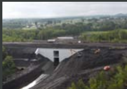
Budowa nowego obiektu mostu-przepustu dla dużej rzeki w nasypie szlaku kolejowego wraz z przebudową koryta rzeki, realizowane jako roboty profilaktyczno-naprawcze w terenie górniczym w zamian podtopionego przepustu
