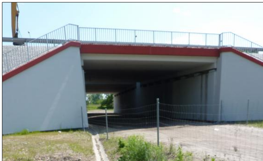
Fot. 9. Widok na dojazd od strony ulic Sejmowej i Szymały w Zabrze (przejazd pod autostradą A4 wymiary prześwitu B x H = 11m x 4,4m).
