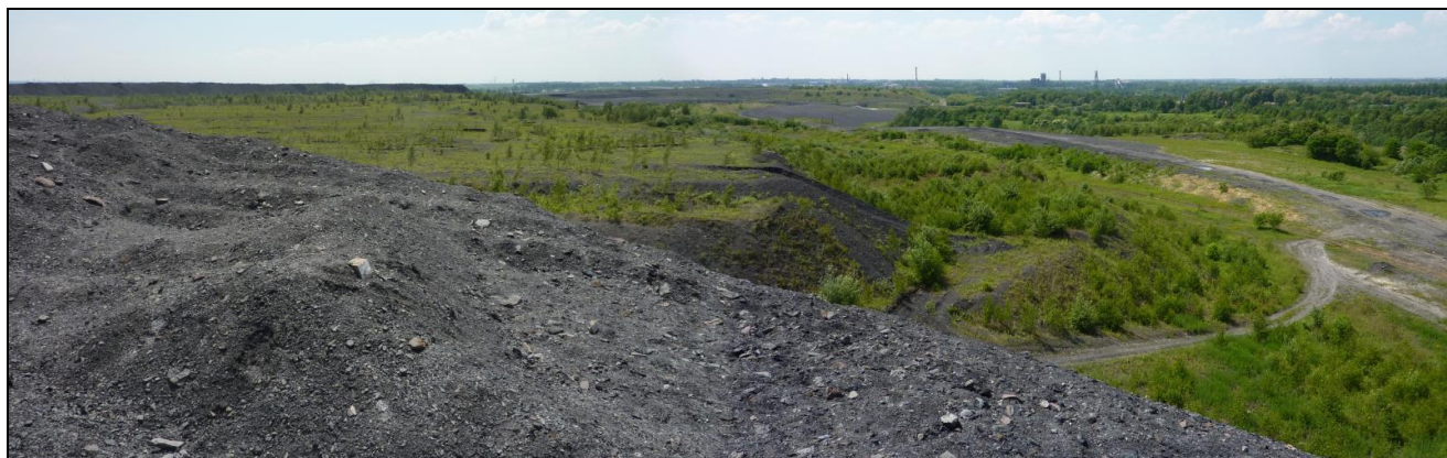
Fot. 4. Widok na środkową część dawnego zwału Sośnica w kierunku zachodnim (Pole B).
