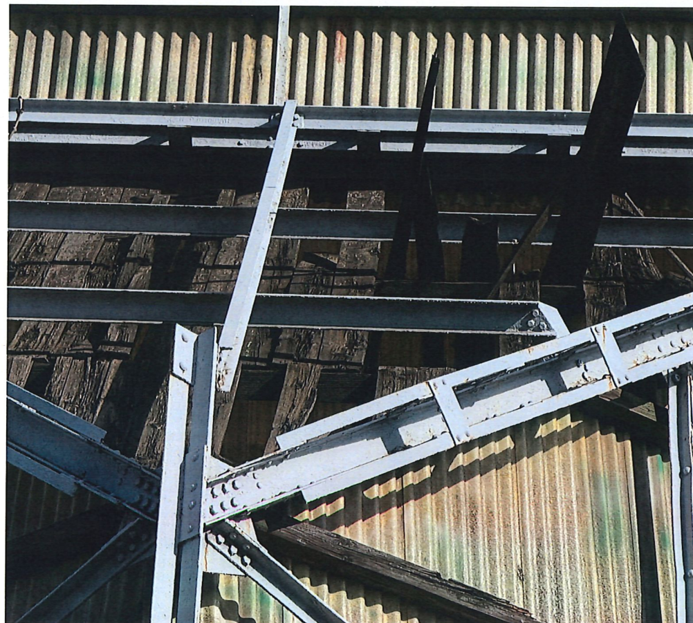
Uszkodzenia płaszcza
