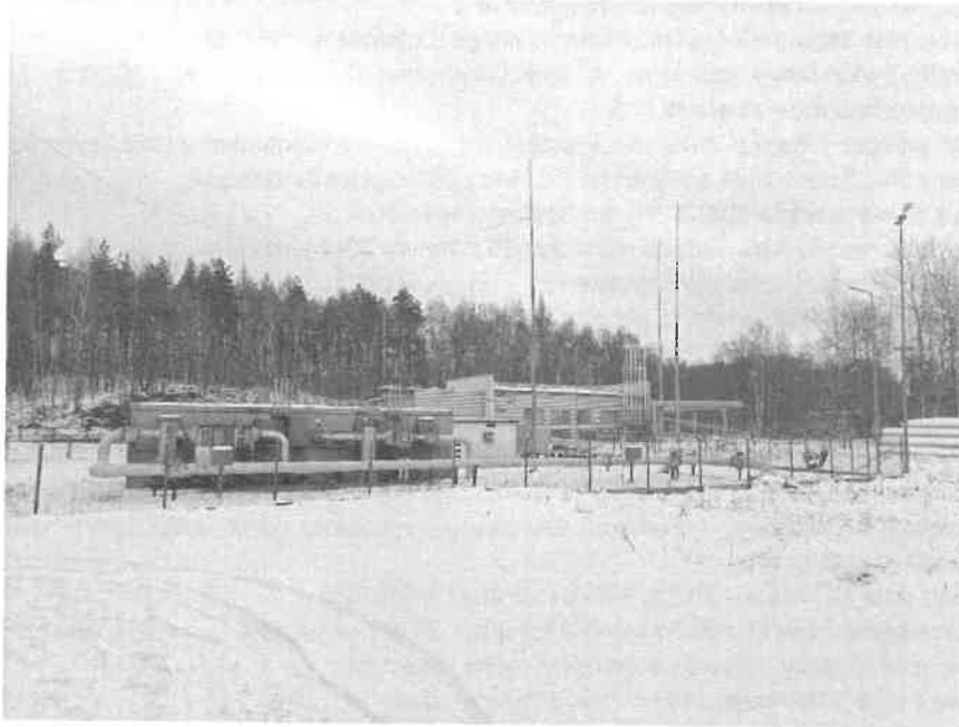
Fot. nr 1 – Teren istniejącej przetłoczni gazu
