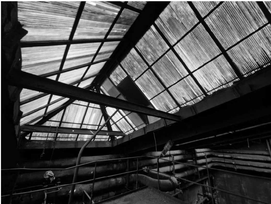
Zdjęcie nr 3. Konstrukcja świetlika – widok od dołu.
