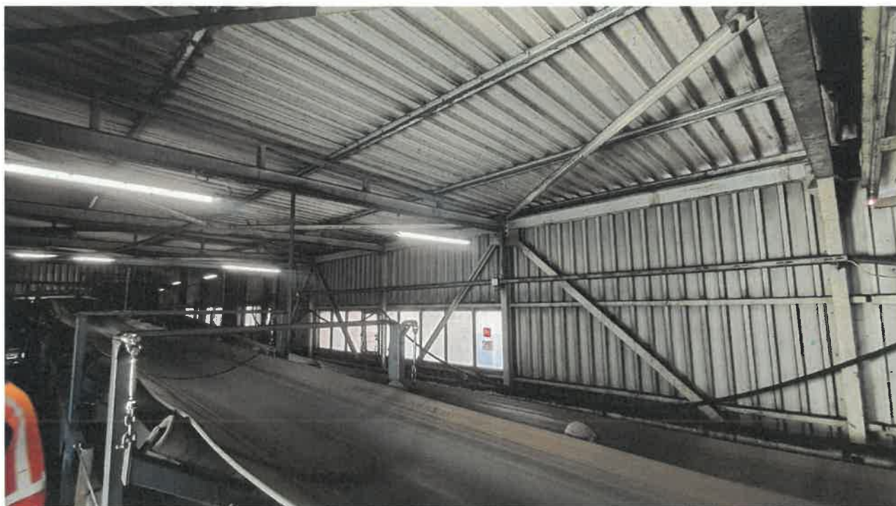
Fot nr 38. Widok od wewnątrz obudowy pomostu w osiach od 22 do 23.
