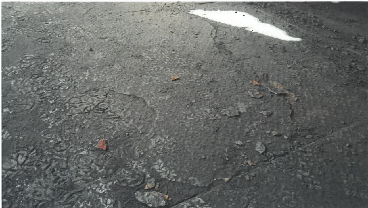
Fot nr 27. Zdjęcie góry posadzki stropu – blacha żeberkowa i jej zaawansowany stopień skorodowania. Zdjęcie wykonane pomiędzy osiami 24 i 25.
