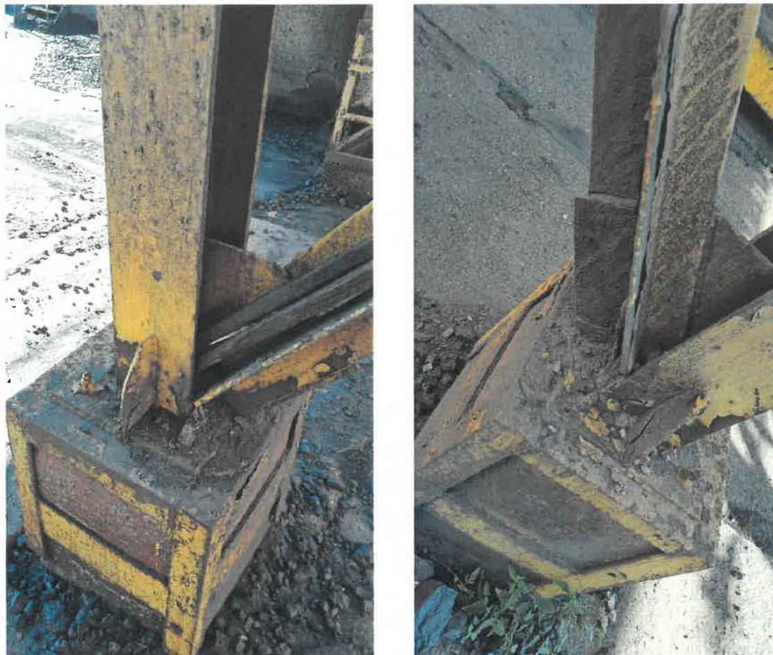
Fot nr 11. Nadziemna część fundamentu w osi 26/C'.
