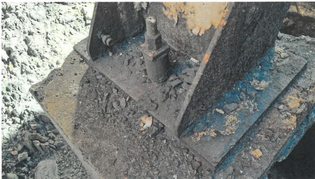
Fot nr 2. Nadziemna część fundamentu w osi 20/D.
