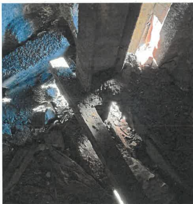
Fot nr 20. Węzeł 19/C dolnego pasu kratownicy, widok od wnętrza pomostu.
