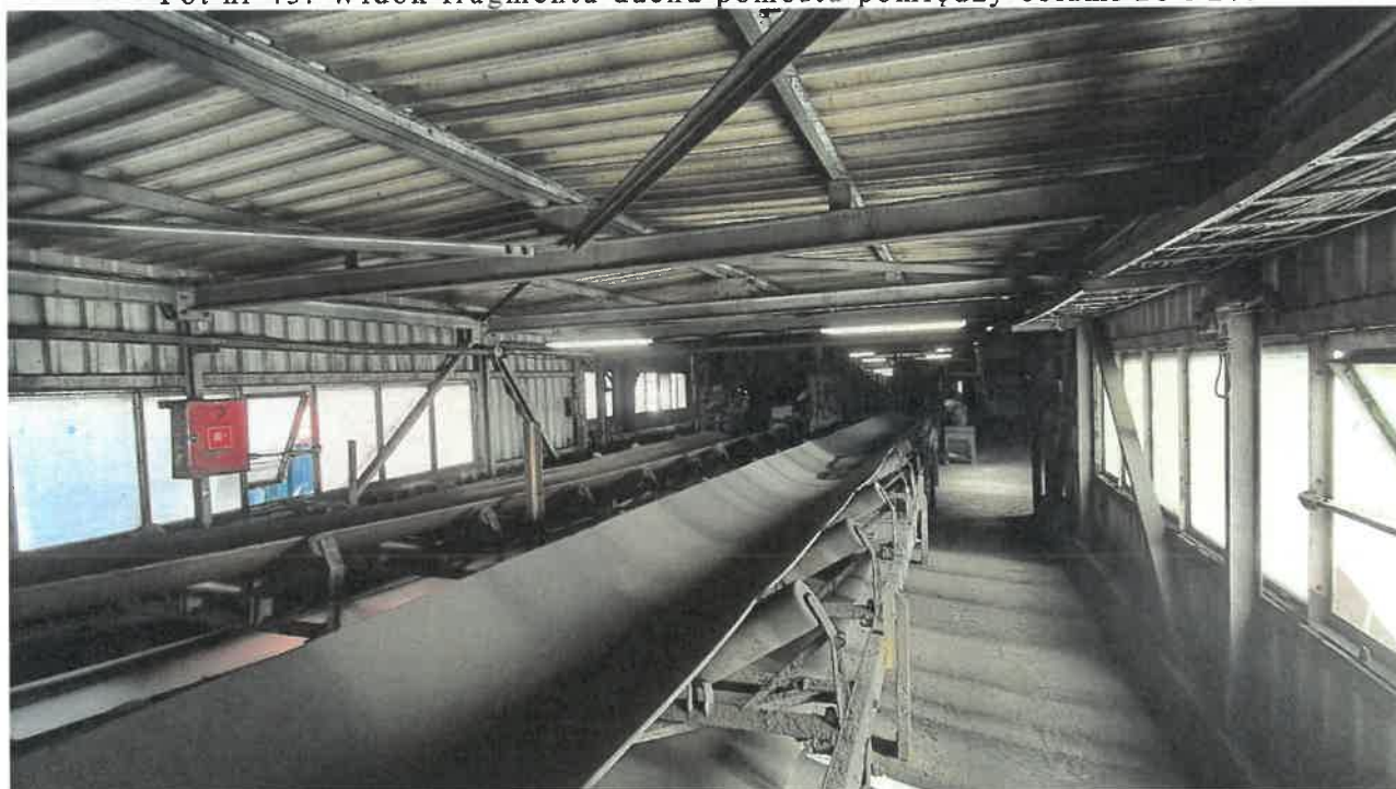
Fot nr 43. Widok fragmentu dachu pomostu pomiędzy osiami 26 i 27.
