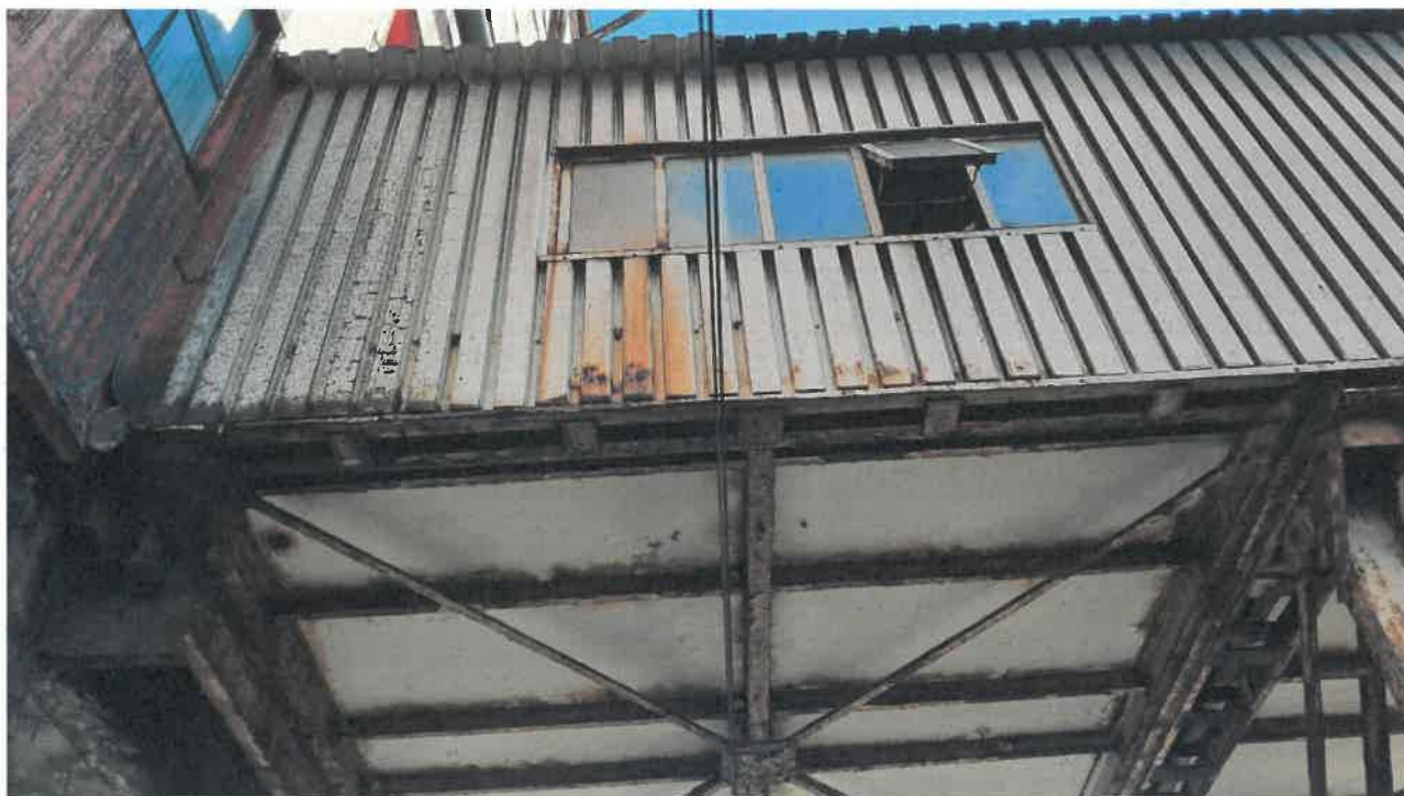
Fot nr 23. Węzeł 19/D; 19+1; 20/D dolnego pasu kratownicy, widok od zewnątrz pomostu.
