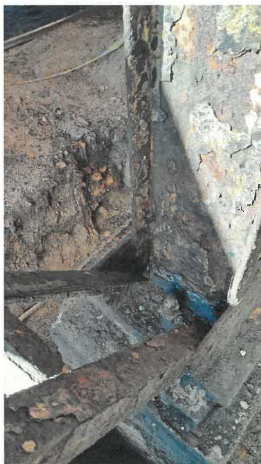
Fot nr 3. Nadziemna część fundamentu w osi 20/D.
