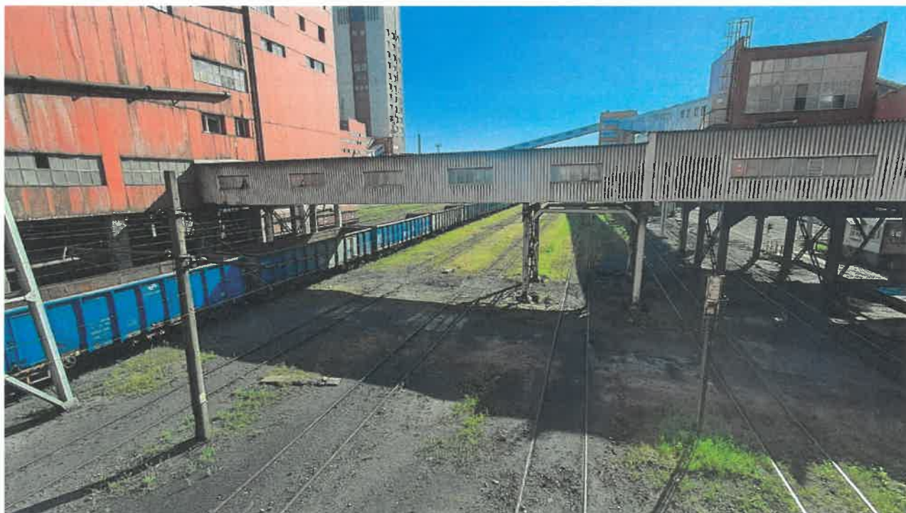
Fot nr 37. Widok od strony wschodniej elewacji pomostu w osiach od 19 do 23.
