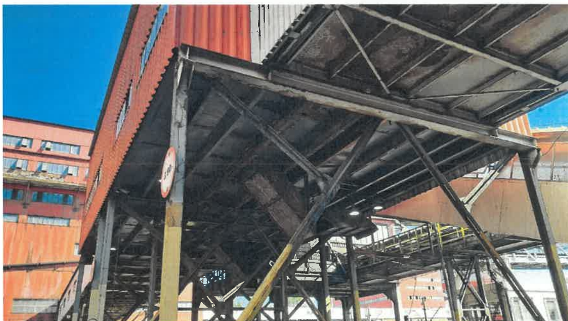
Fot nr 25. Węzeł 26/D; 26/C dolnego pasu kratownicy, widok od zewnątrz pomostu.
