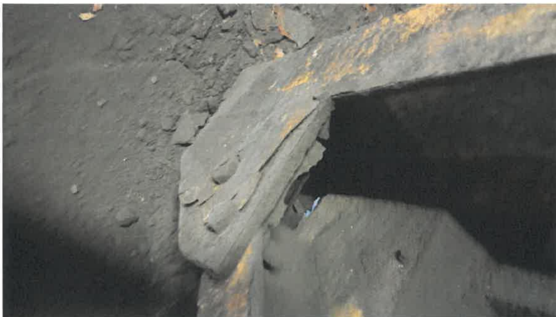
Fot nr 24. Węzeł 23/C dolnego pasu kratownicy, widok od wnętrza pomostu.
