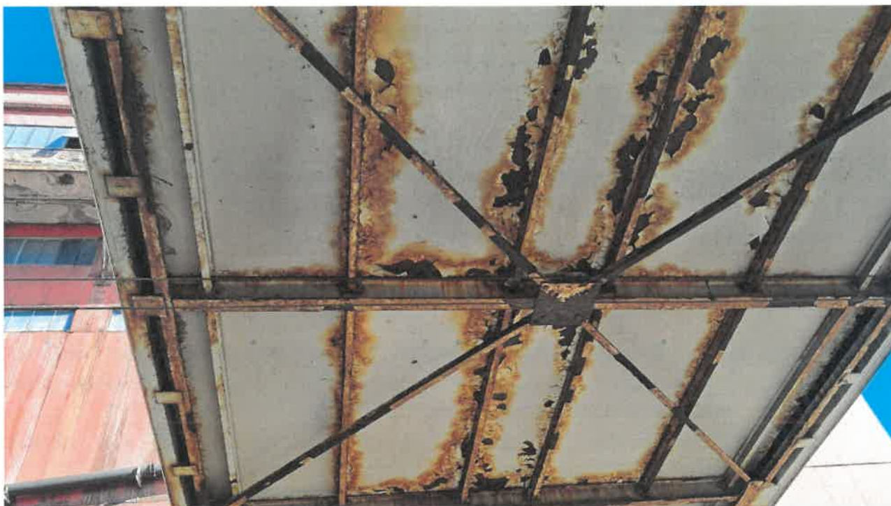
Fot nr 26. Zdjęcie stropu widziane od zewnątrz pomostu z dołu w osi od 20/DC do 20+2/DC.
