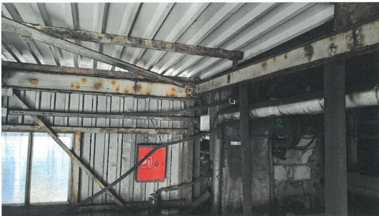
Fot nr 13. Węzeł 19/D górnego pasu kratownicy.
