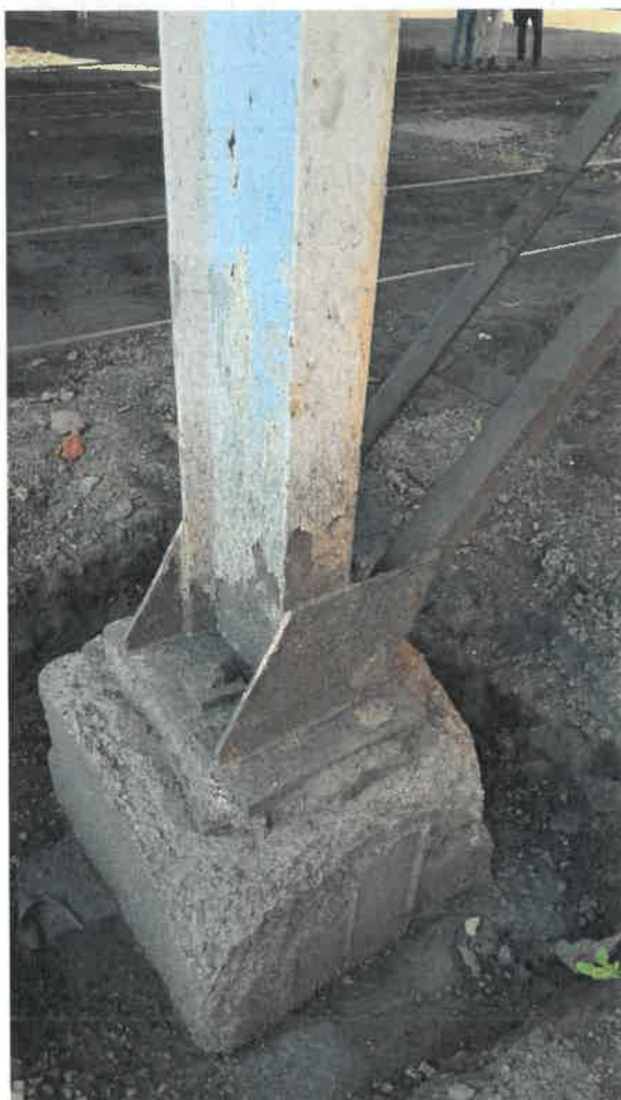
Fot nr 28. Słup 22/C i 25C' w miejscu podporowej fundamentu.
