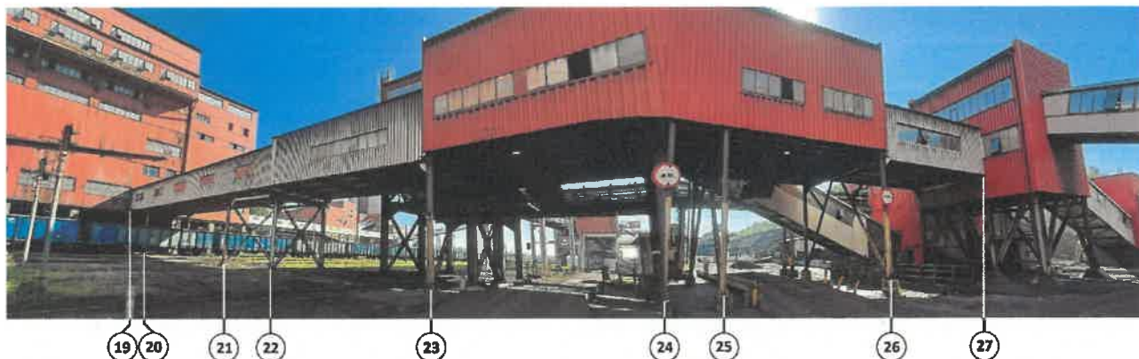
Fot. nr 1. Pomostu technolo. 706, 232 wraz ze stacją pośrednią - widok strona wschodnia.
