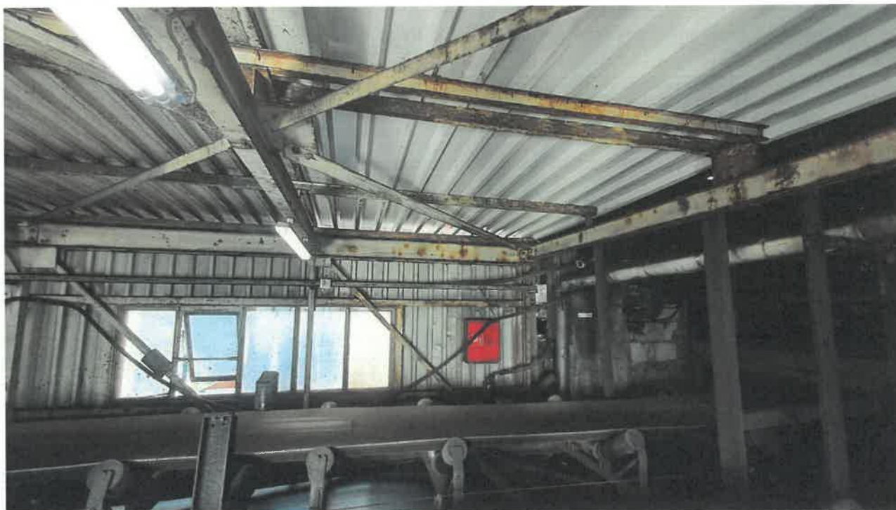
Fot nr 45. Widok fragmentu dachu stacji załadowniczej pośredniej pomiędzy w okolicy osi 19.
