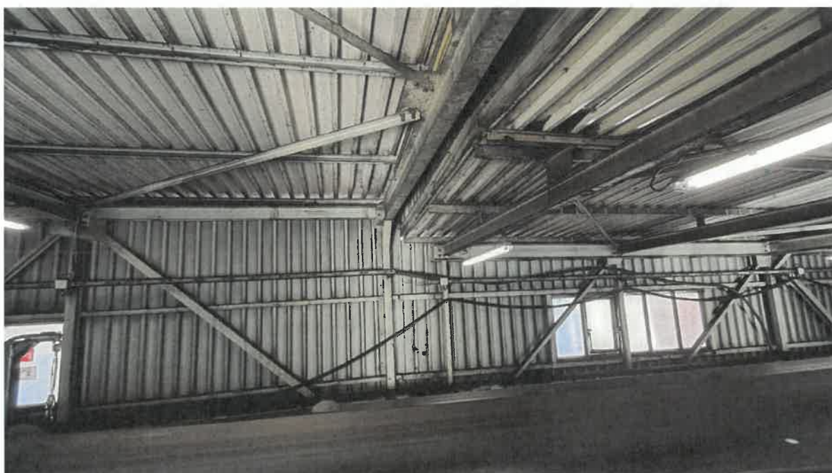
Fot nr 18. Węzeł 23+1/D'; 23/D.; 23D'; 22+3/D górnego pasu kratownicy.
