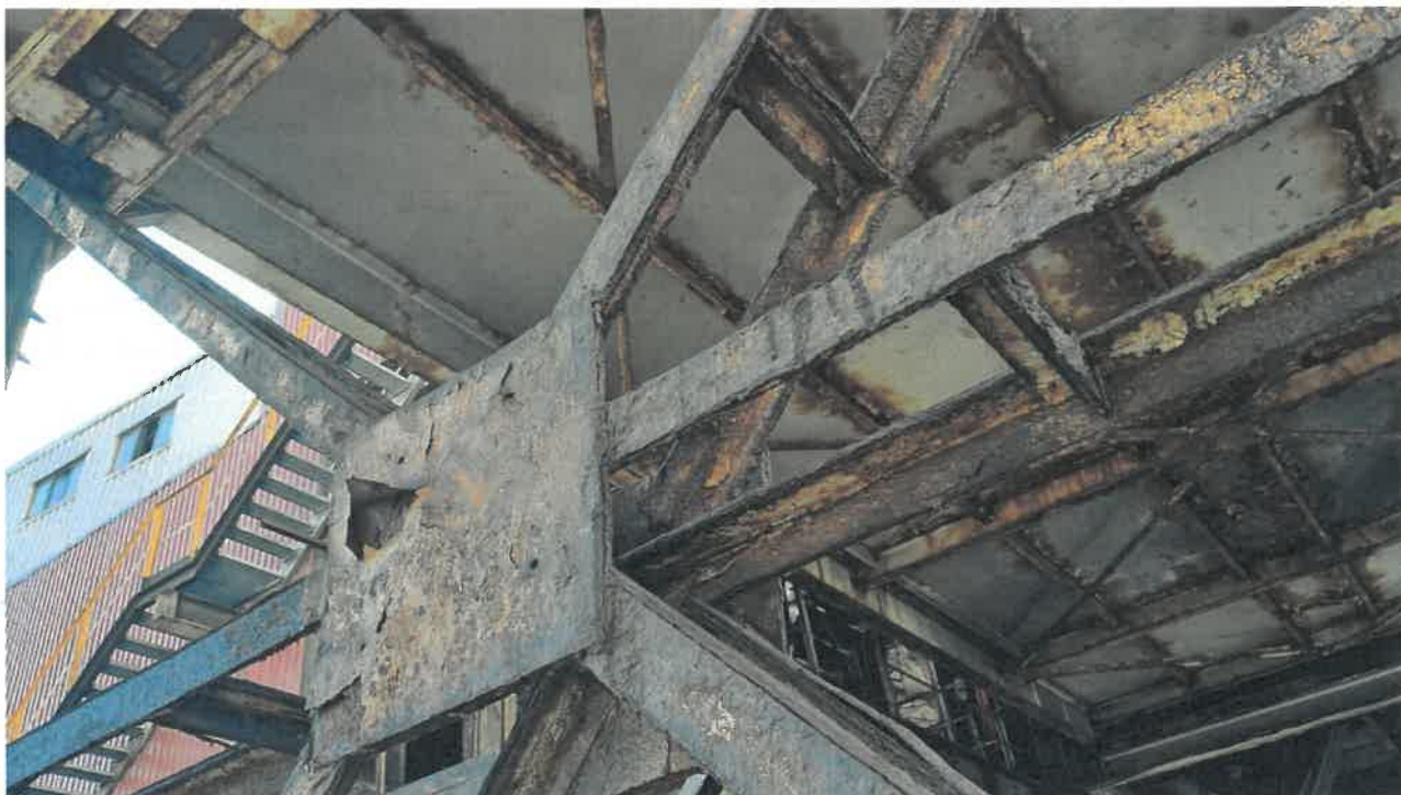
Fot nr 32. Widok stężenia ramy podporowej w osi 22.
