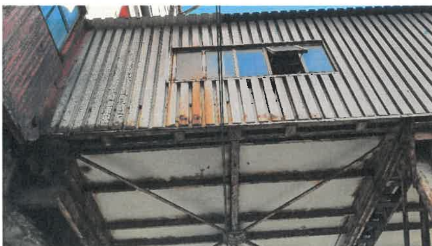
Fot nr 45. Widok ślusarki okiennej w polu pomiędzy osiami 19-20/D.
