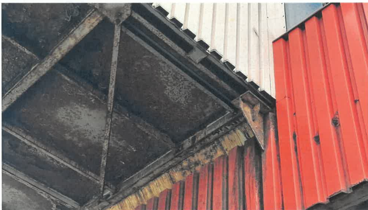
Fot nr 25. Węzeł 27/D dolnego pasu kratownicy, widok od zewnątrz pomostu.
