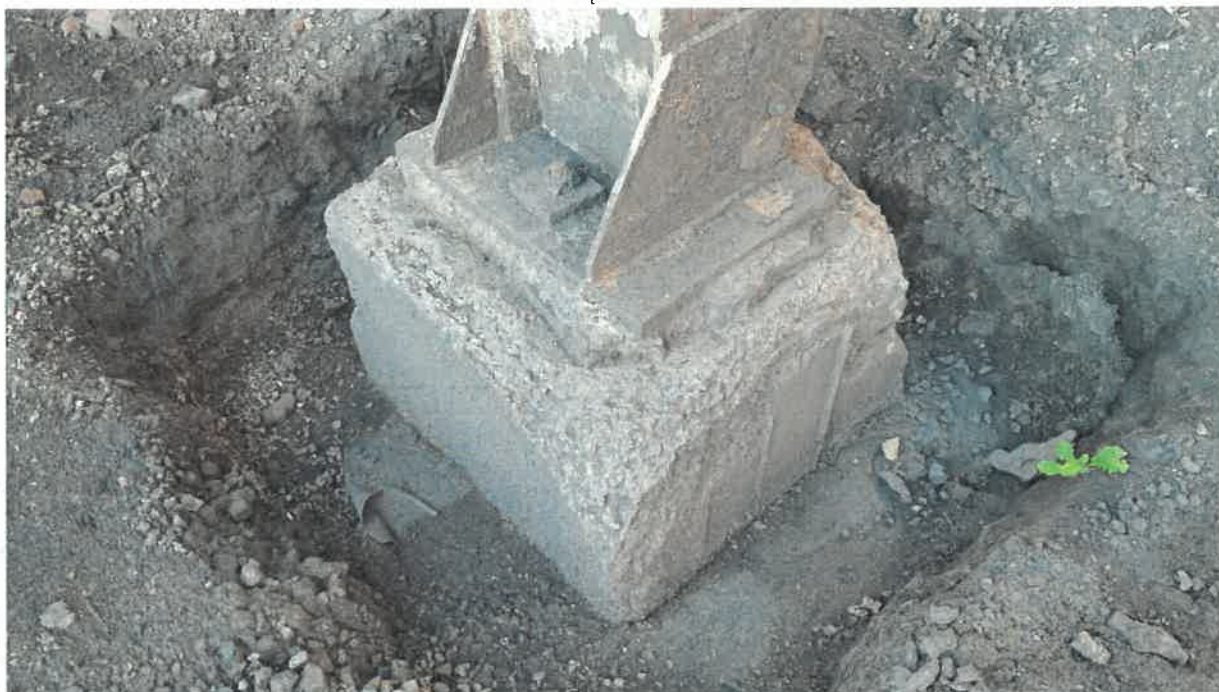
Fot nr 7. Nadziemna część fundamentu w osi 22/C.
