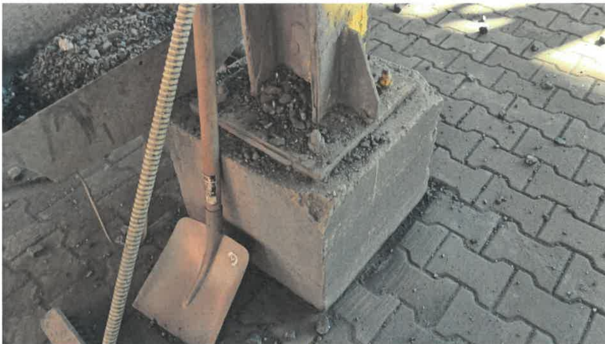
Fot nr 9. Nadziemna część fundamentu w osi 24/C'.
