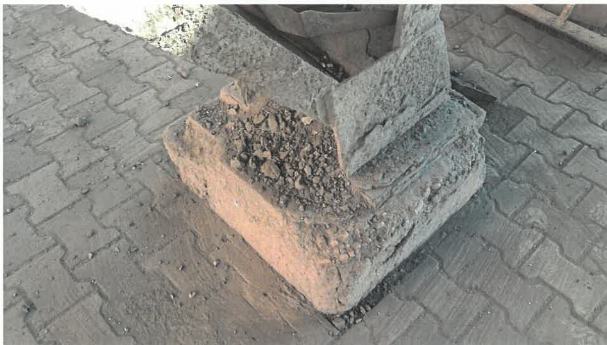
Fot nr 8. Nadziemna część fundamentu w osi 24/C.
