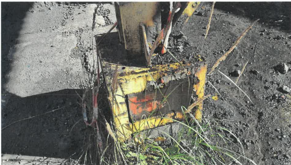
Fot nr 10. Nadziemna część fundamentu w osi 26/C'.
