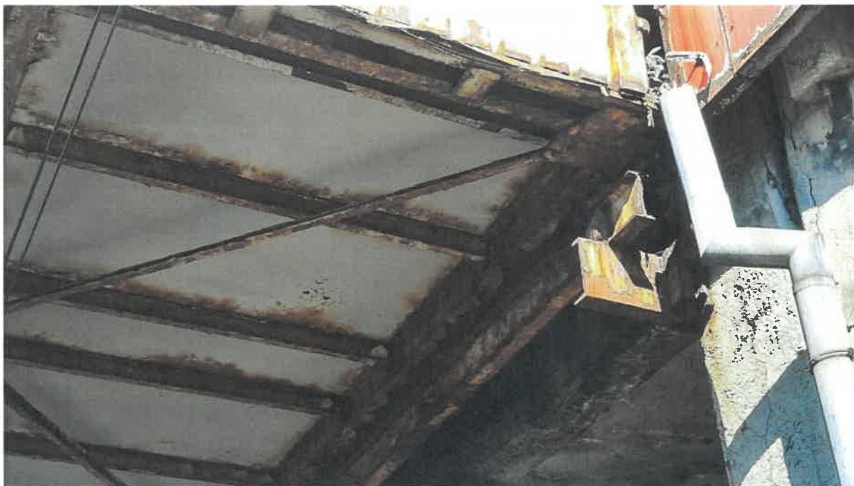
Fot nr 21. Węzeł 19/C dolnego pasu kratownicy, widok od zewnątrz pomostu.
