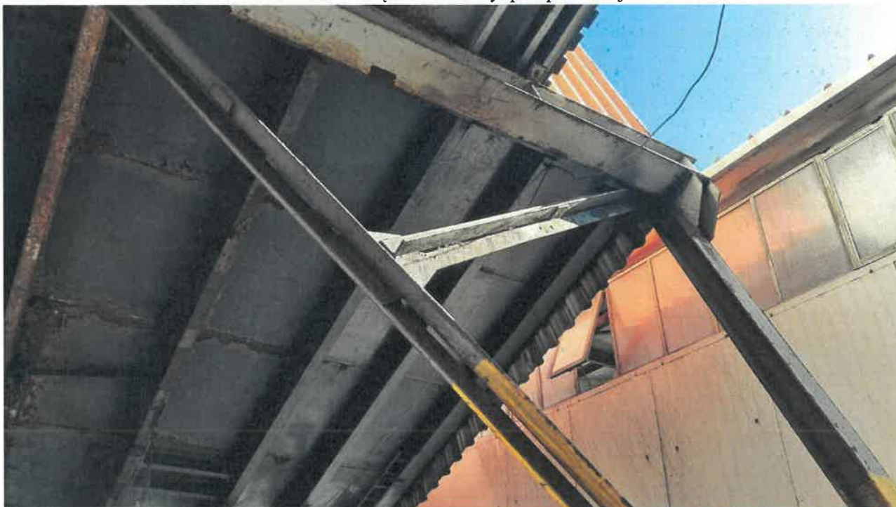
Fot nr 33. Widok stężenia ramy podporowej w osi 26.
