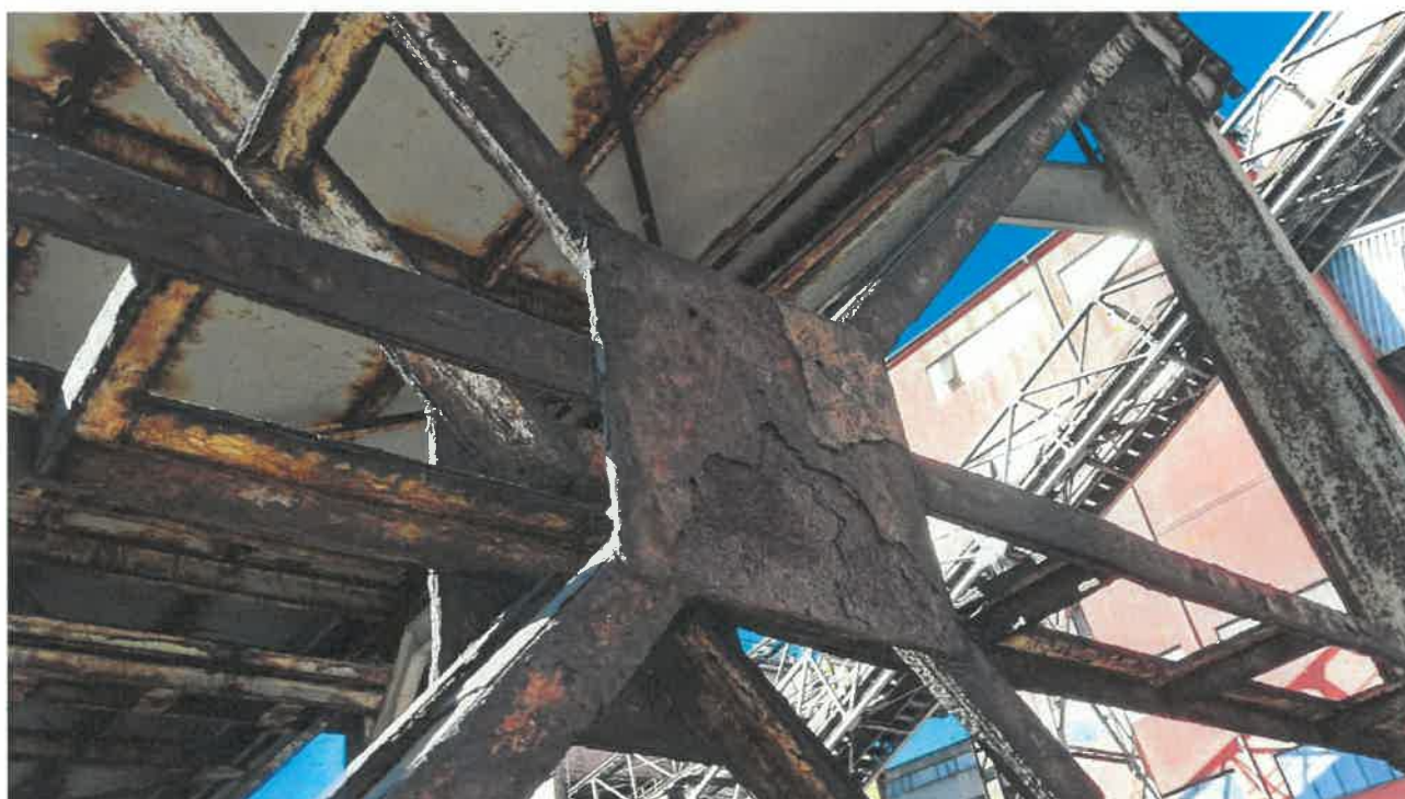
Fot nr 31. Widok stężenia ramy podporowej w osi 21.
