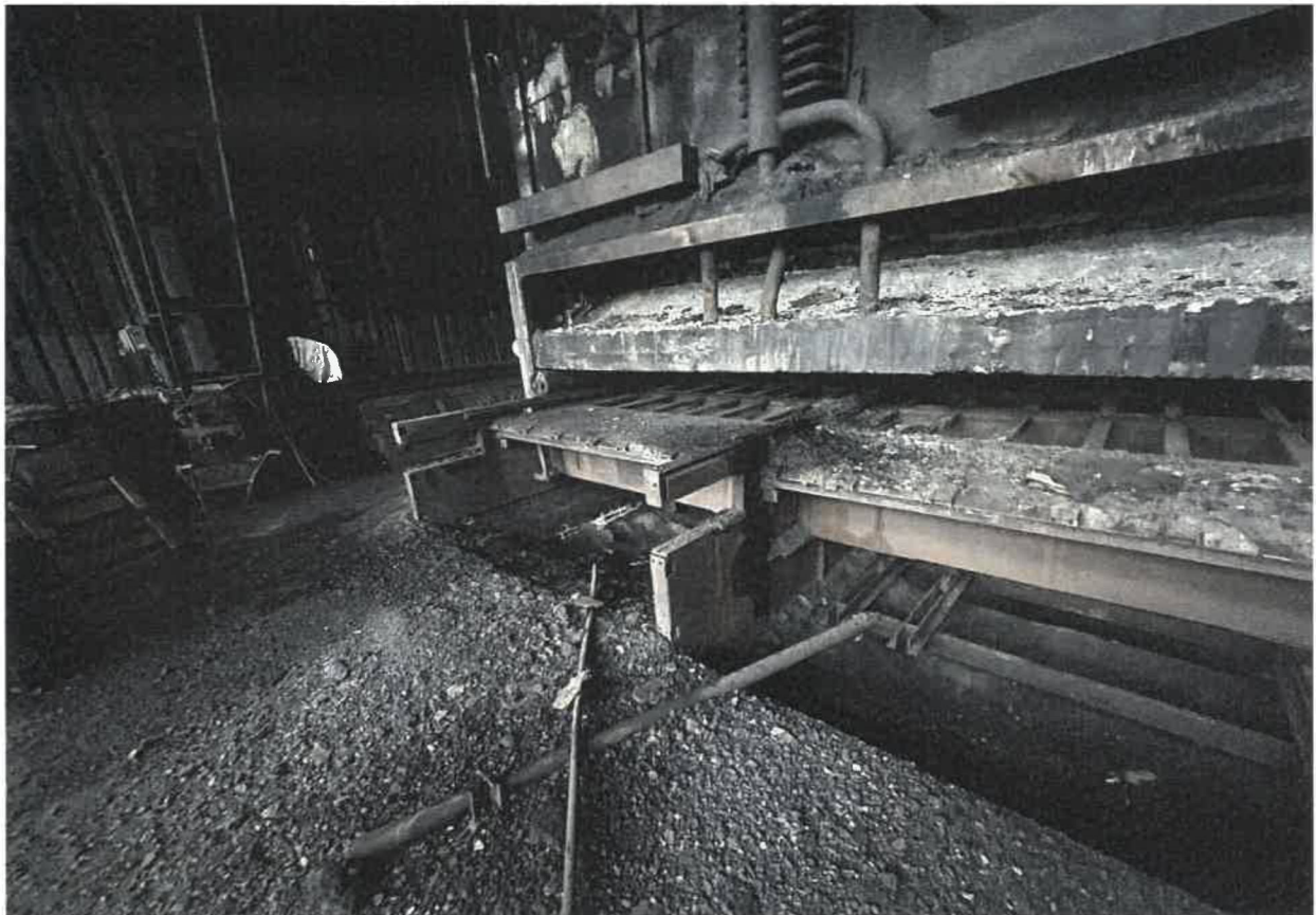
Zdjęcie nr 12 – widok bunkra / zasobnika węgla do rozbiórki
