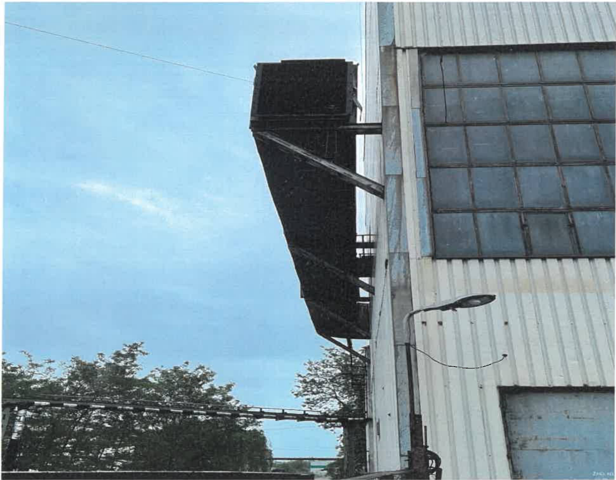
Zdjęcie nr 4, 5, 6 – widok słupów żelbetowych do demontażu – rozbiórka do poziomu posadzki.
