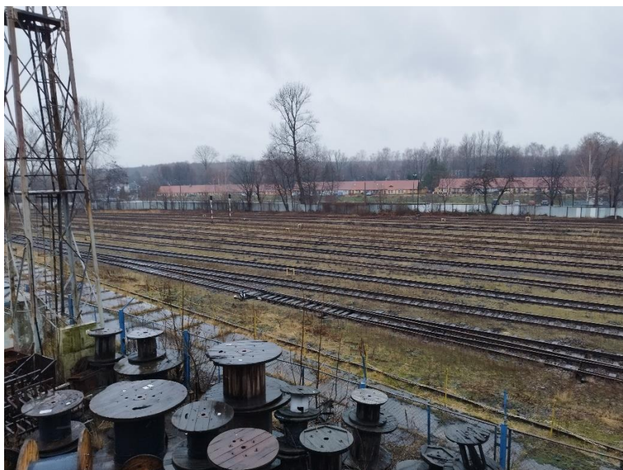
1. Bocznica kolejowa część południowo zachodnia
