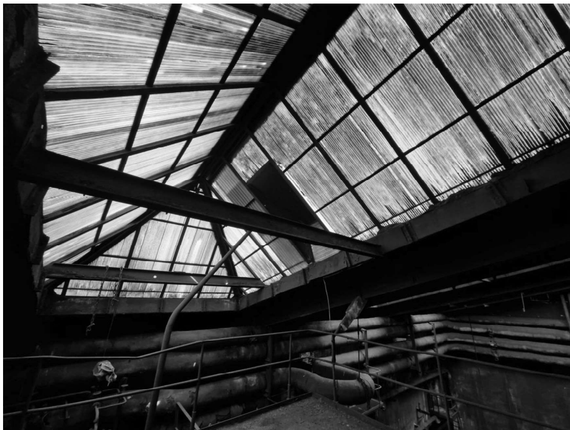
Zdjęcie nr 3. Konstrukcja świetlika – widok od dołu.
