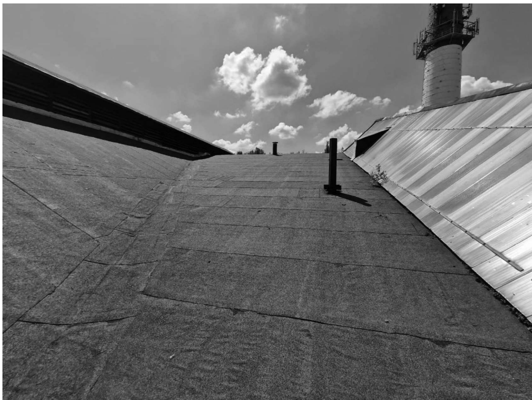
Zdjęcie nr 17. Dach budynku kotłowni.
