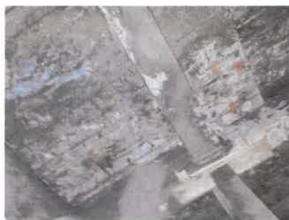
Płyta stropowa – widoczna znaczna korozja płyty stropowej /zdjęcia źródłowe/
