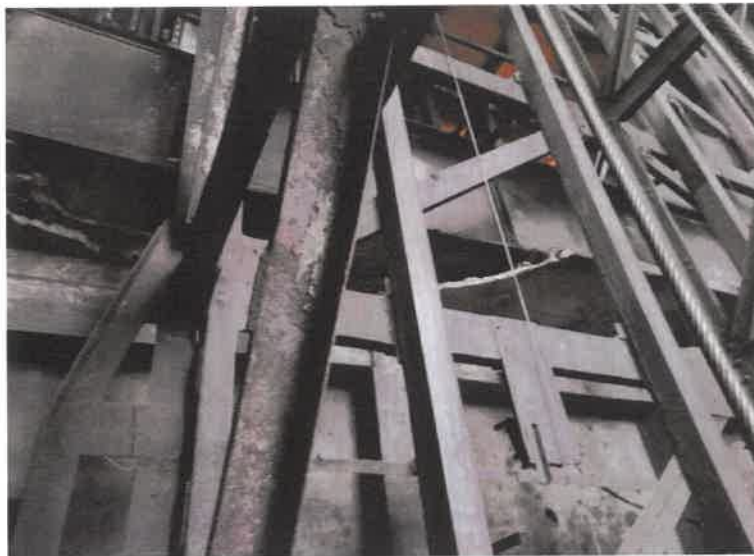
Zdjęcia – widoczna awaria pomostu na poziomie + 6.50 m od strony stalowego trzonu prowadniczego /zdjęcia źródłowe/
