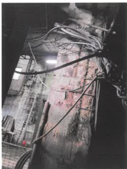
Słupy od strony trzonu prowadniczego widoczna znaczna korozja słupów
