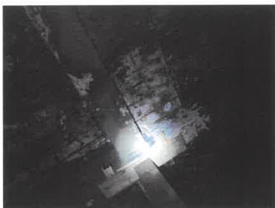
Belki żelbetowe – poz. 6 – widoczna miejscowa korozja belek /zdjęcia źródłowe/
