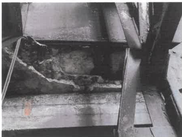
Zdjęcia: uszkodzenia stropu + 6.50 m na pomoście / galerii Widoczne częściowe wypadnięcie płyty stropowej – stan awaryjny /zdjęcia źródłowe/
