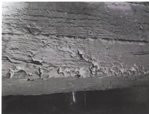
Belka podciągowa nr 3,4,5 – widoczna miejscowa korozja belek /zdjęcia źródłowe/
