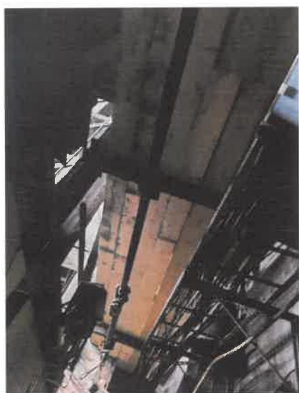
Zdjęcia – widoczna awaria pomostu na poziomie + 6.50 m od strony stalowego trzonu prowadniczego /zdjęcia źródłowe/
