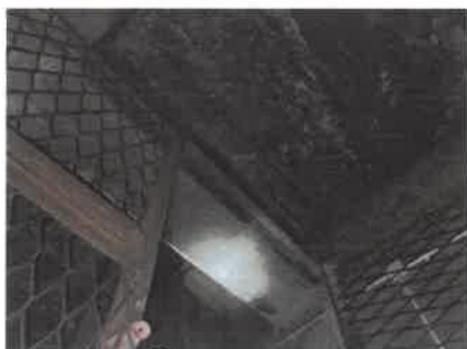
Płyta stropowa – widoczna znaczna korozja płyty stropowej /zdjęcia źródłowe/
