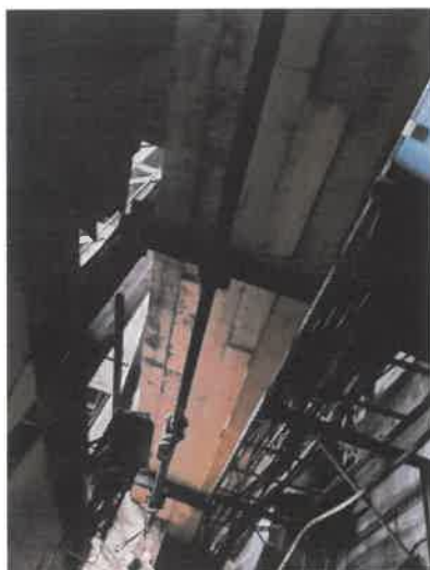
Zdjęcia: zabezpieczenia stropu + 6.50 m pod pomostem / galerią po awarii /zdjęcia źródłowe/
