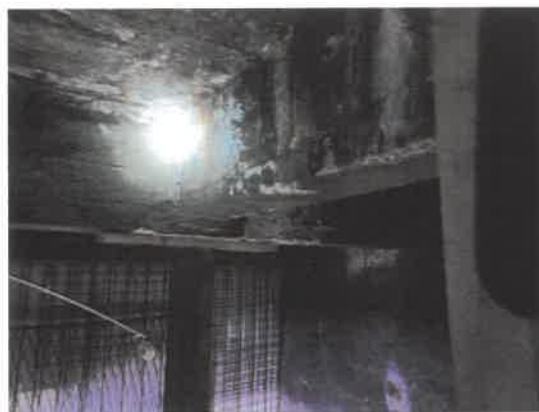
Belki żelbetowe – poz. 6 – widoczna miejscowa korozja belek /zdjęcia źródłowe/
