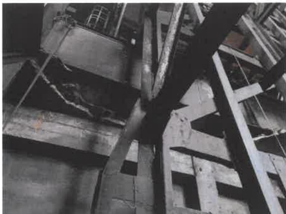
Zdjęcia: uszkodzenia stropu + 6.50 m na pomoście Widoczne częściowe zerwanie się płyty stropowej /zdjęcia źródłowe/
