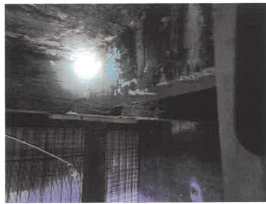
Belka podciągowa nr 2 – widoczne uszkodzenia belki oraz jej podparcie tymczasowe /zdjęcia źródłowe/
