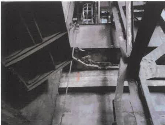
Zdjęcia: uszkodzenia stropu + 6.50 m na pomoście Widoczne częściowe zerwanie się płyty stropowej /zdjęcia źródłowe/
