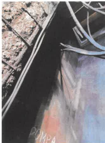
Słupy od strony trzonu prowadniczego – widoczna znaczna korozja słupów /zdjęcia źródłowe/
