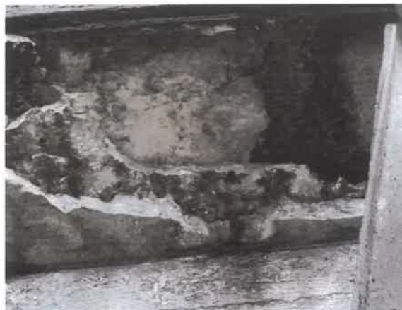
Zdjęcia: uszkodzenia stropu + 6.50 m na pomoście / galerii Widoczne częściowe wypadnięcie płyty stropowej – stan awaryjny /zdjęcia źródłowe/
