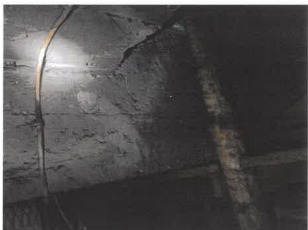
Belka podciągowa nr 3,4,5 – widoczna miejscowa korozja belek /zdjęcia źródłowe/
