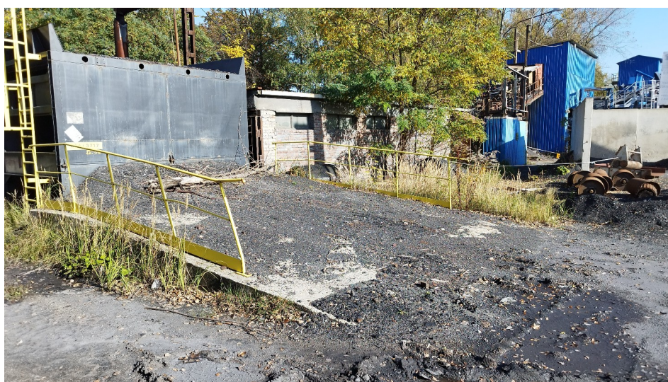
Fot. 11 Rampa - widok od strony południowej.
