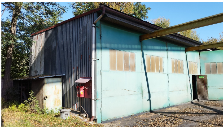
Fot. 8 Budynek warsztatu JPR nr 2 - widok od strony południowej.
