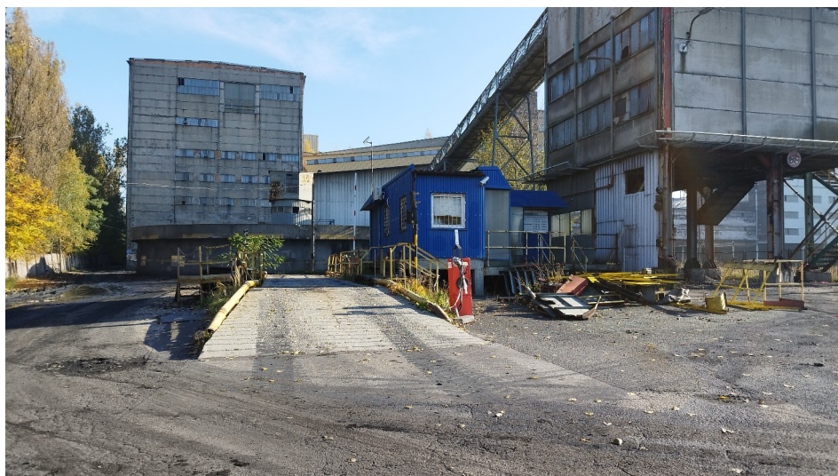
Fot. 3 Waga "Junior" wraz z kontenerem oraz kontener wagi "Junior" - widok od strony południowo-zachodniej.
