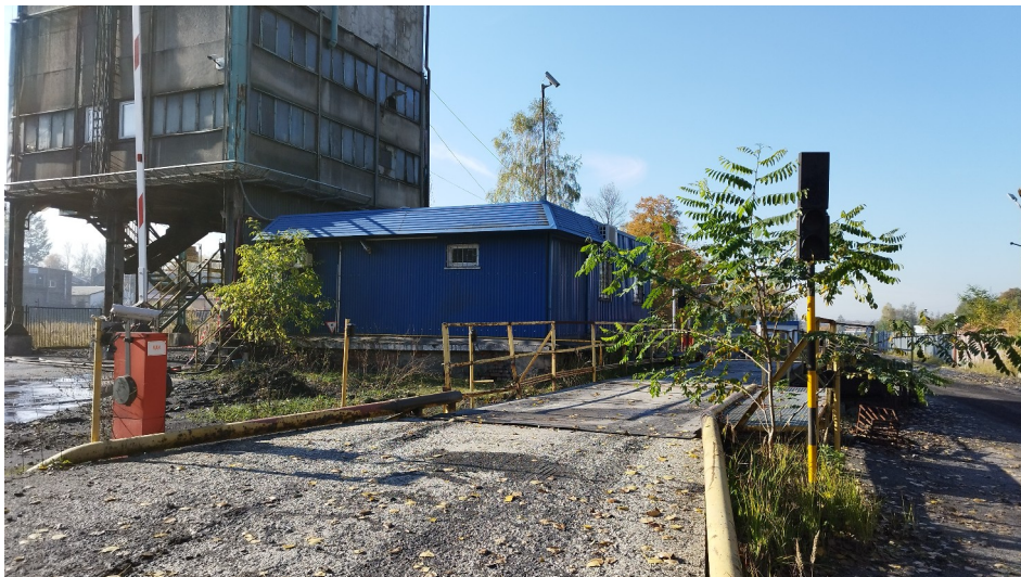
Fot. 4 Waga "Junior" wraz z kontenerem oraz kontener wagi "Junior" - - widok od strony północnej.
