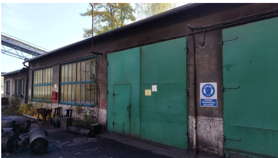
Fot. 6 Budynek warsztatu JPR nr 1 - widok od strony południowo-zachodniej.
