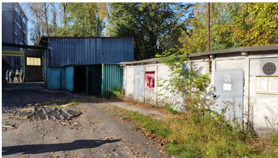
Fot. 9 Budynek warsztatu JPR nr 2 - widok od strony północno-wschodniej.
