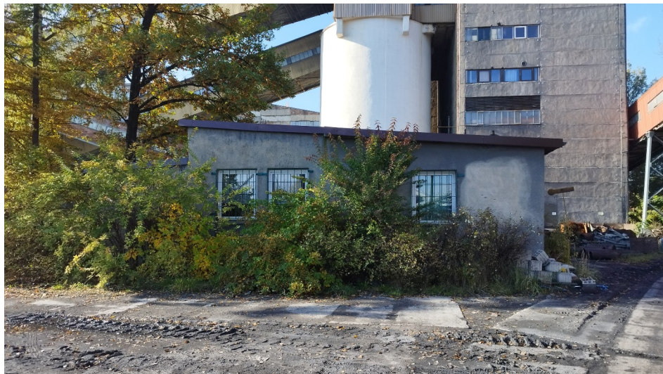
Fot. 7 Budynek warsztatu JPR nr 1 - widok od strony północno-wschodniej.
