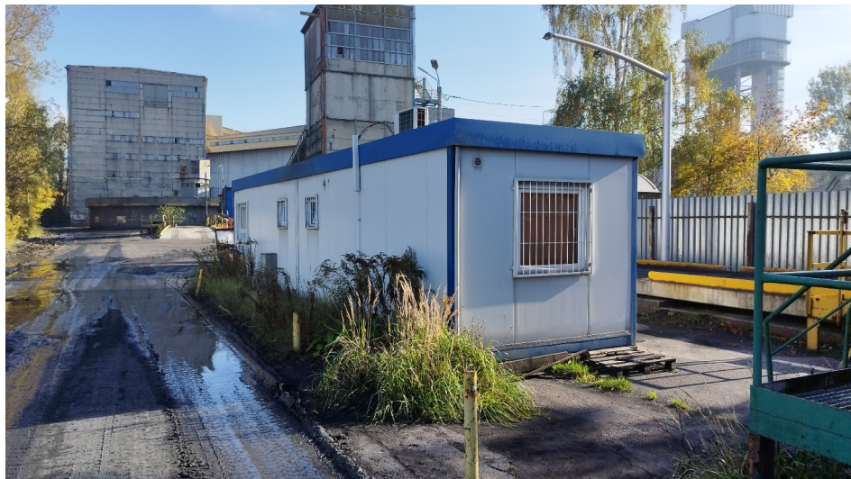
Fot. 1 Kontener wagi "CARBO" - widok od strony południowo-zachodniej.
