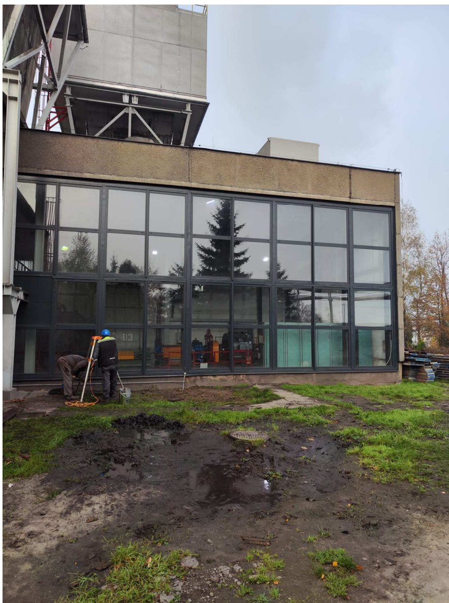
fot. 6.5 Nowe okna w budynku SWG na innym obiekcie
