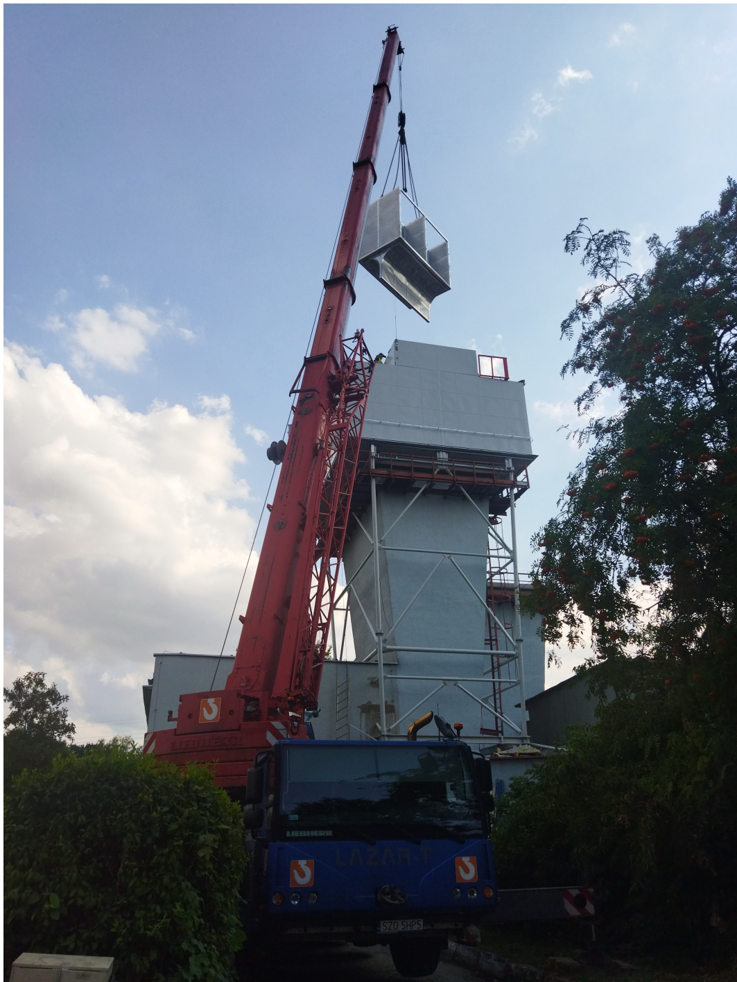
fot. 6.2 Transport wkładu tłumika
