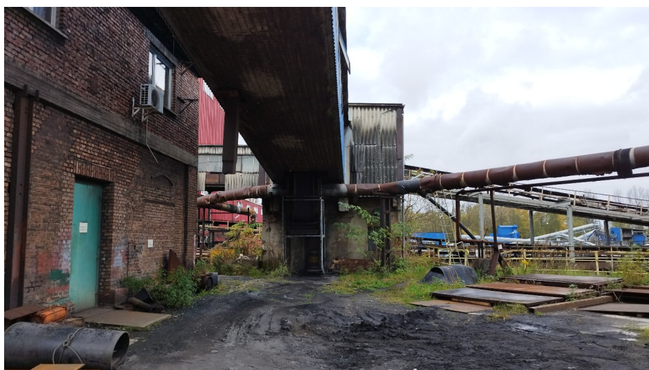
Fot. 21 Stacja przesypowa 703/804 z pomostem - widok od strony południowej.
