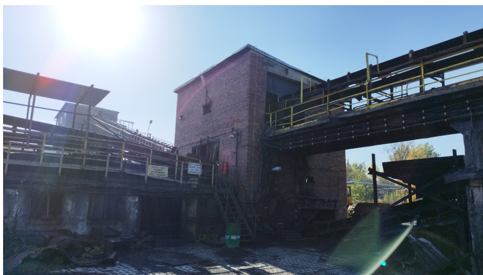
Fot. 27 Stacja przesypowa 7/9 - widok od strony północnej.
