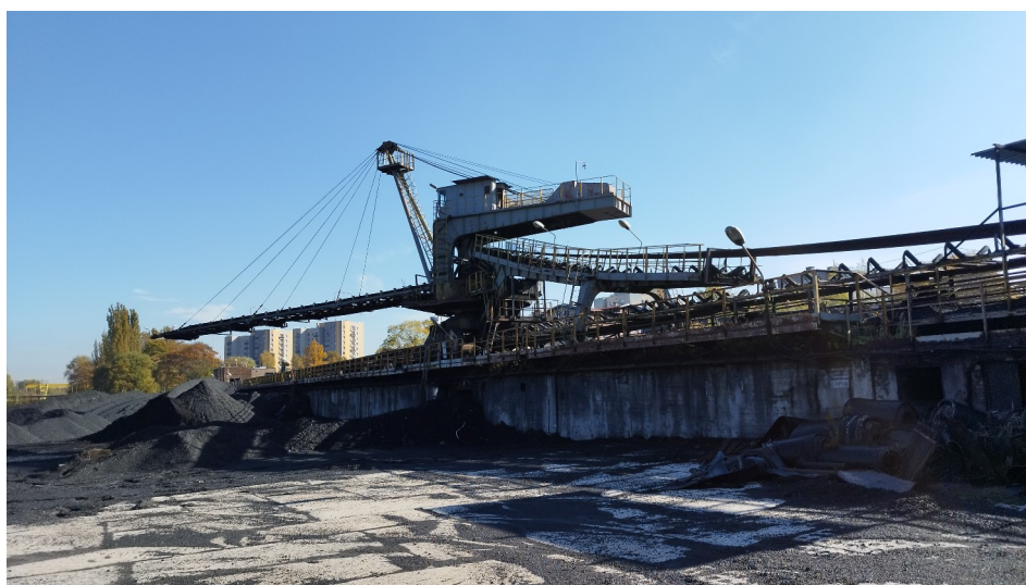
Fot. 30 Pomost zwalowarki 'ZOWA' wraz z budynkiem napędu przenośnika taśmowego 9 i torowiskiem - widok od strony północno-zachodniej.
