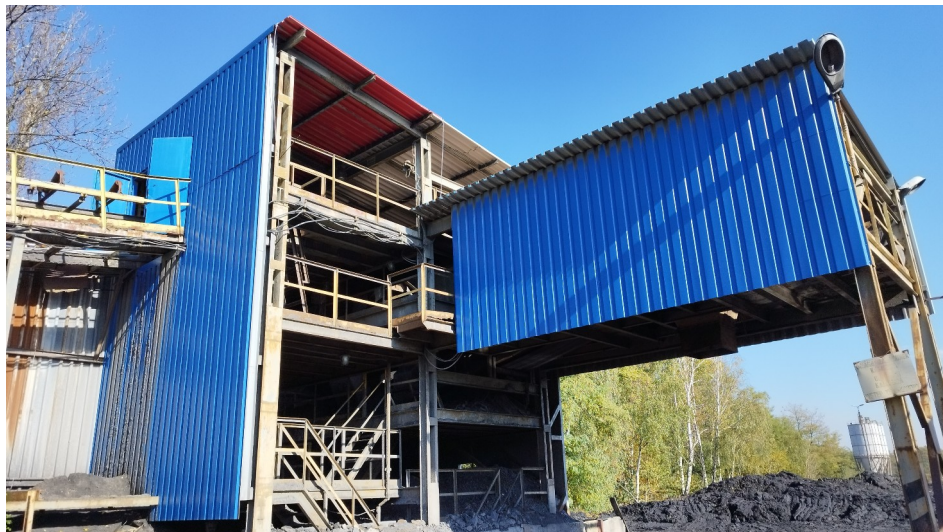
Fot. 16 Stacja przesypowa 940G/941 - widok od strony południowej.
