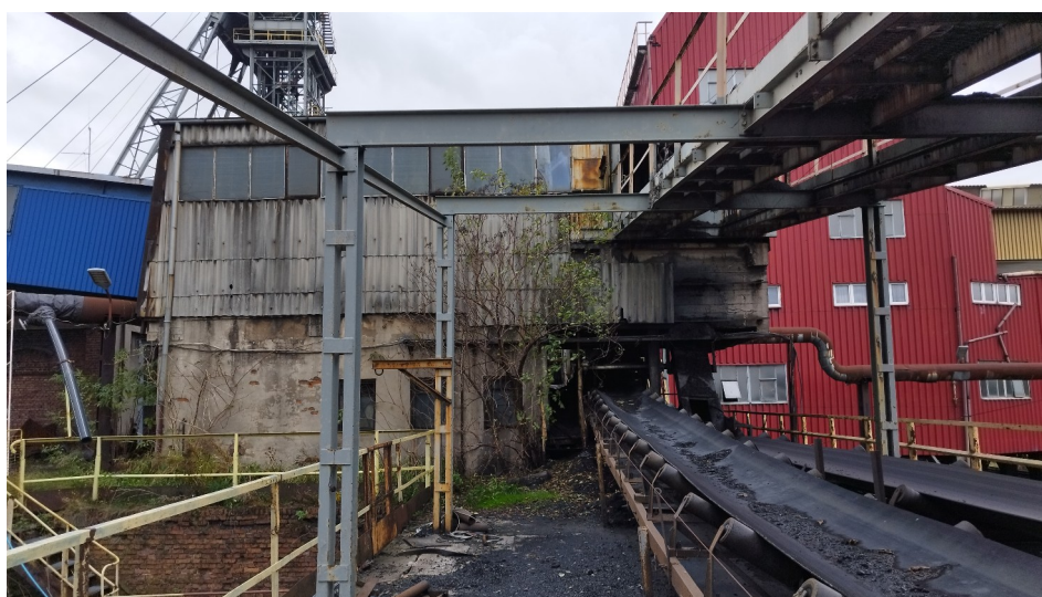
Fot. 20 Stacja przesypowa 703/804 z pomostem - widok od strony północno-wschodniej.
