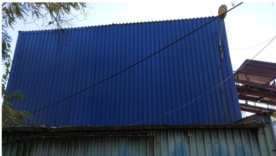
Fot. 14 Kruszarnia polowa - widok od strony północnej.
