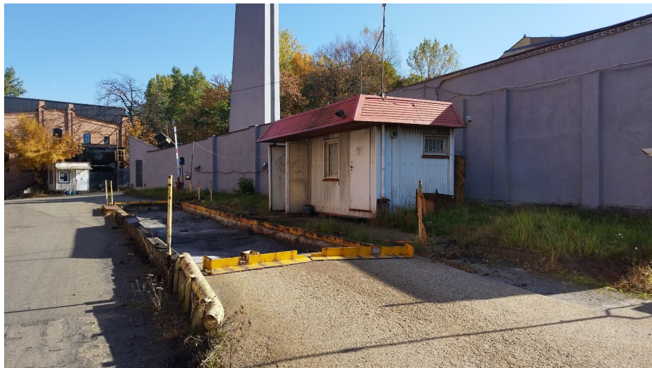
Fot. 19 Waga samochodowa wraz z kontenerem - widok od strony zachodniej.
