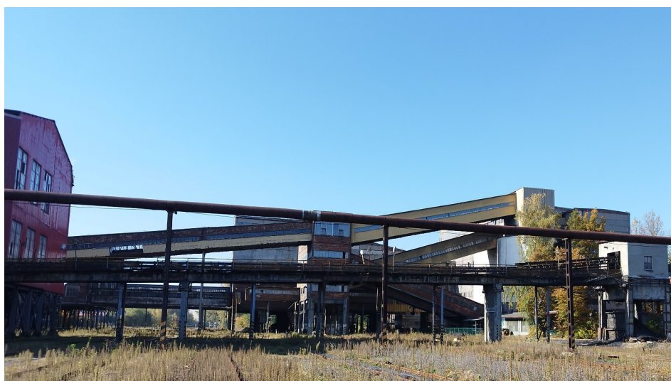
Fot. 18 Pomost przenośnika taśmowego 913 - widok od strony północno-wschodniej.
