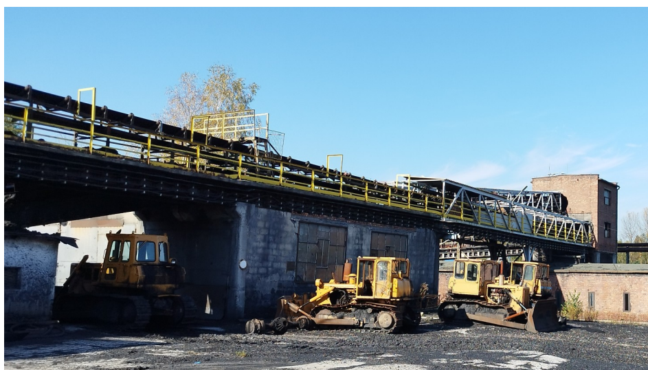
Fot. 24 Pomost przenośnika taśmowego 7 - widok od strony wschodniej.
