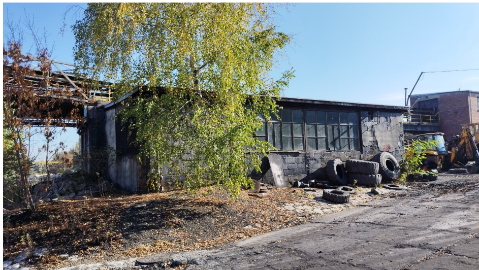
Fot. 25 Budynek warsztatu - plac składowy urobku - widok od strony zachodniej.
