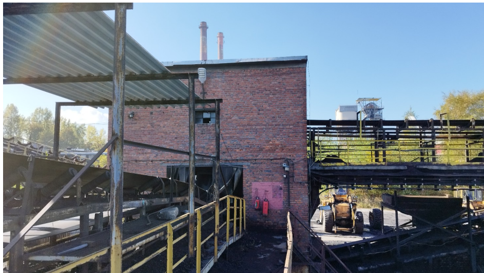
Fot. 28 Stacja przesypowa 7/9 - widok od strony wschodniej.
