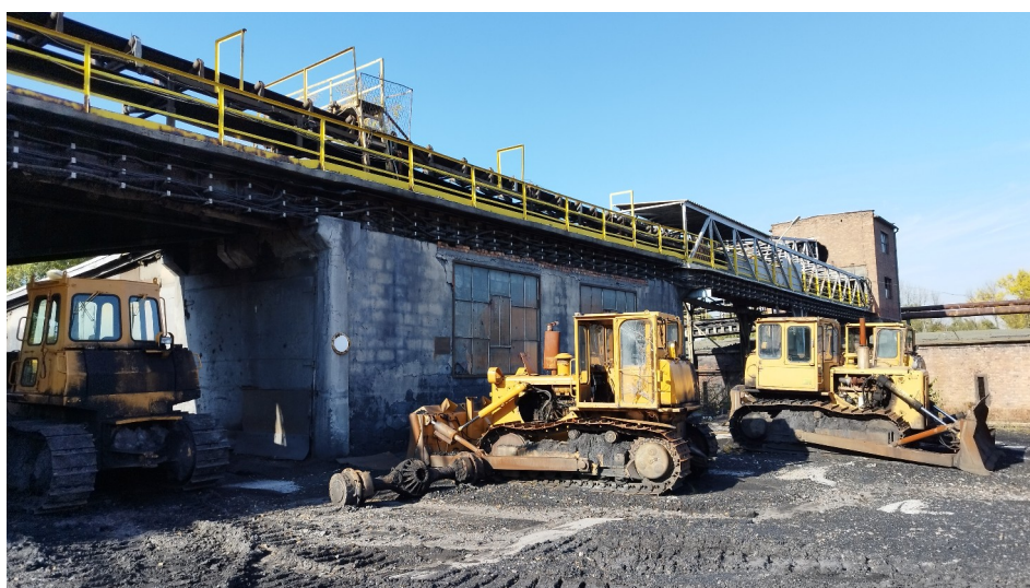
Fot. 26 Budynek warsztatu - plac składowy urobku - widok od strony południowo-wschodniej.
