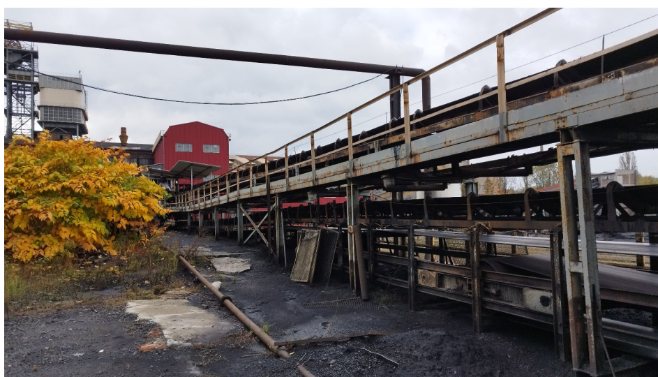
Fot. 23 Pomost przenośnika taśmowego 804 - widok od strony wschodniej.
