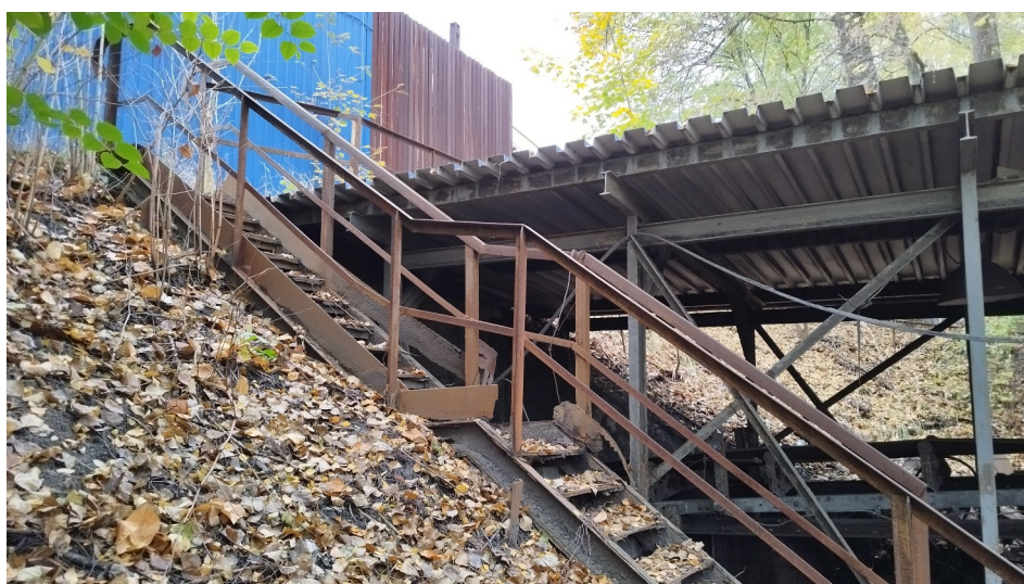
Fot. 17 Tunel przenośnika taśmowego 941 - widok od strony północno-wschodniej.
