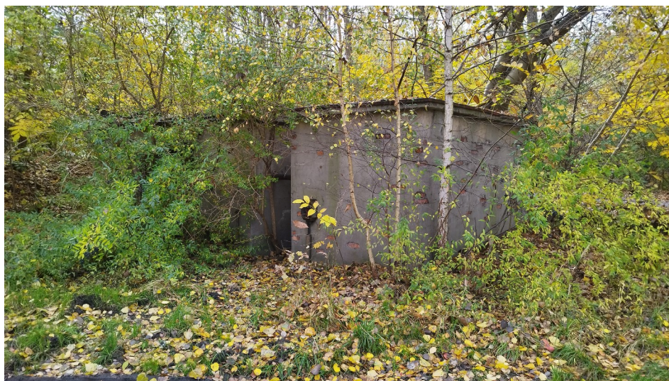
Fot. 32 Pompownia wód popłuczkowych - widok od strony wschodniej.
