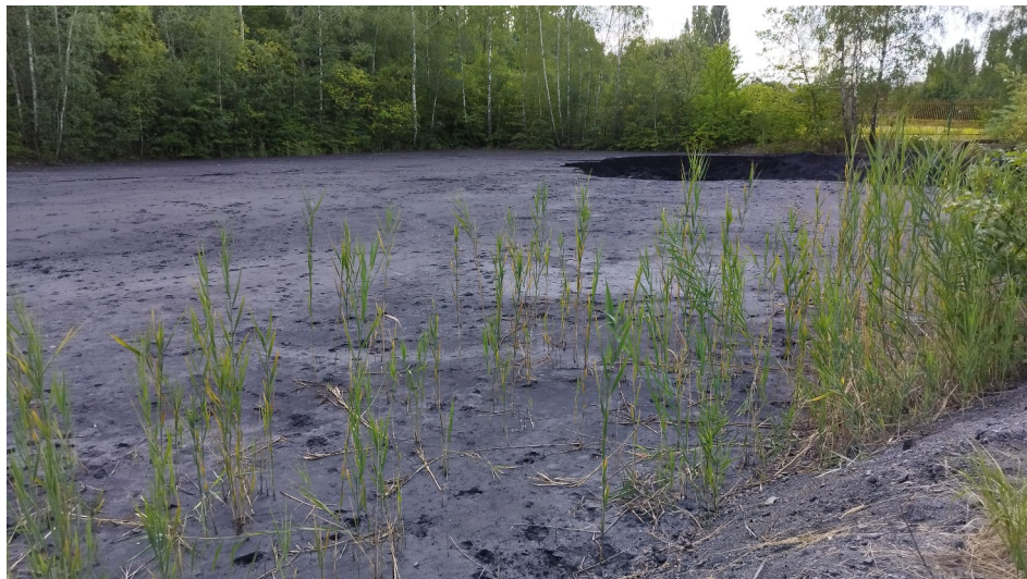
Fot. 31 Osadnik wód popłuczkowych ziemny, węglony - widok od strony północnej.
